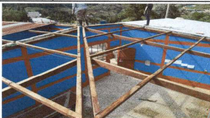
Foto 2: Sustitución de lámina, por lámina troquelada aluzinc calibre 26 y sustitución de bajada de agua pluvial de metal por tubo PVC 3".
