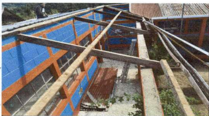
Foto 3: Sustitución de lámina, por lámina troquelada aluzinc calibre 26 y sustitución de bajada de agua pluvial de metal por tubo PVC 3".
