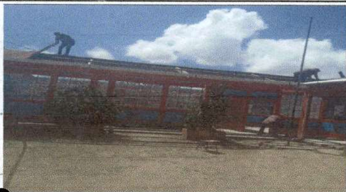
Foto 1: Sustitución de lámina, por lámina troquelada aluzinc calibre 26 y sustitución de bajada de agua pluvial de metal por tubo PVC 3".
